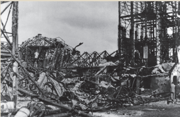
被害を受けた日石構内の建物
